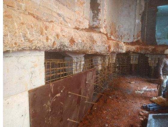
Figura 10. Parede de concreto envolvendo as estacas mega abaixo de alvenaria interna.
