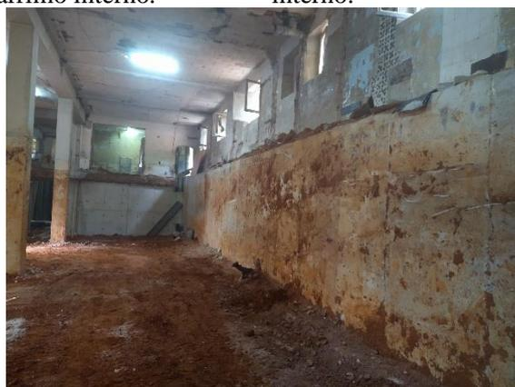
Figura 4. Subsolo interno na cota final de escavação.
