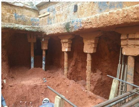
Figura 7. Estacas mega apoiando a fachada, com escavação até a cota do subsolo.
