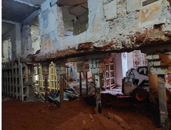
Figura 9. Estacas mega para apoio de alvenarias internas.
