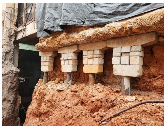
Figura 6. Detalhe dos blocos para encunhamento das estacas.
