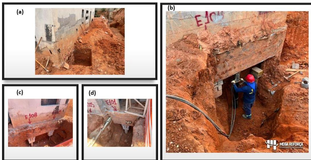
Figura 8. Execução das estacas mega na obra
